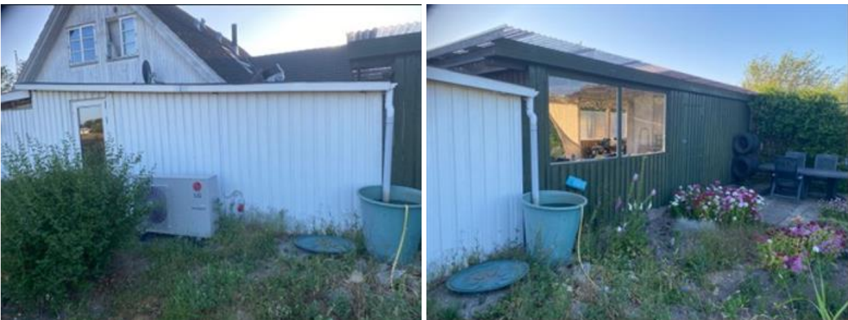
Billeder af garage og overdækket terrasse fra ansøgningsmaterialet.
