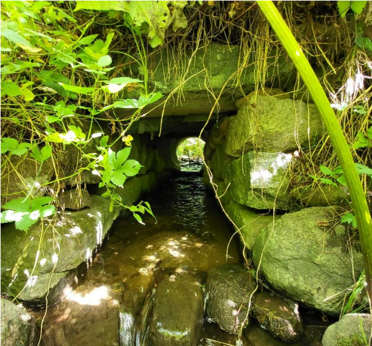
Billede 3.1.1: Billede af den velbevarede stenkiste, der i nyere tid er blevet forlænget opstrøms med betonrør.
