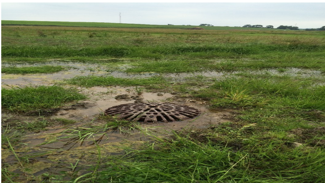
Figur 13: Eksempel på ny vældbrønd og afledning til risleområde (Orbicon - Odder Ådal). Dog skal de hæves 15 cm over terræn og omkringlagt sikringssten.
