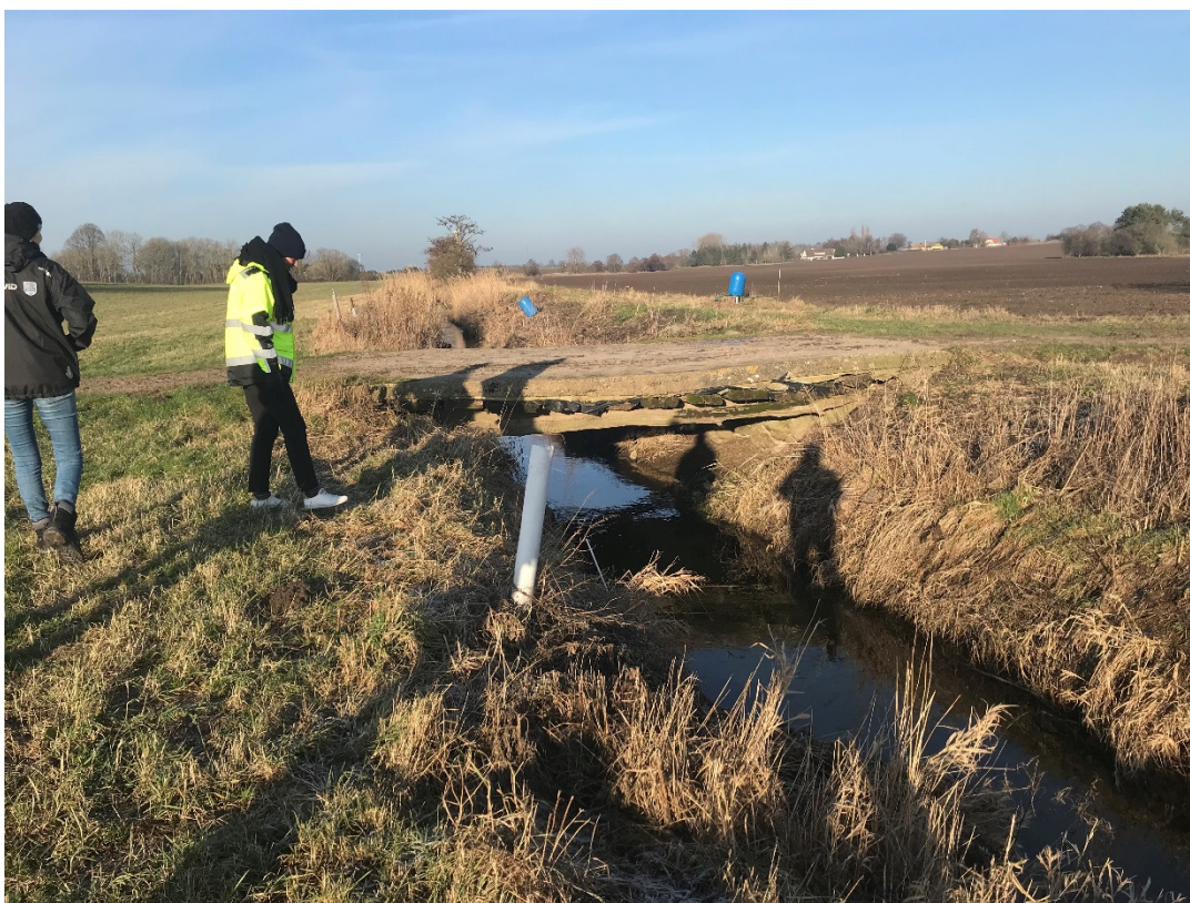
Figur 19: Nuværende overkørsel ved Harrested Å's st. ca. 1.000. Pumpestationen m. blå spand i baggrunden.
