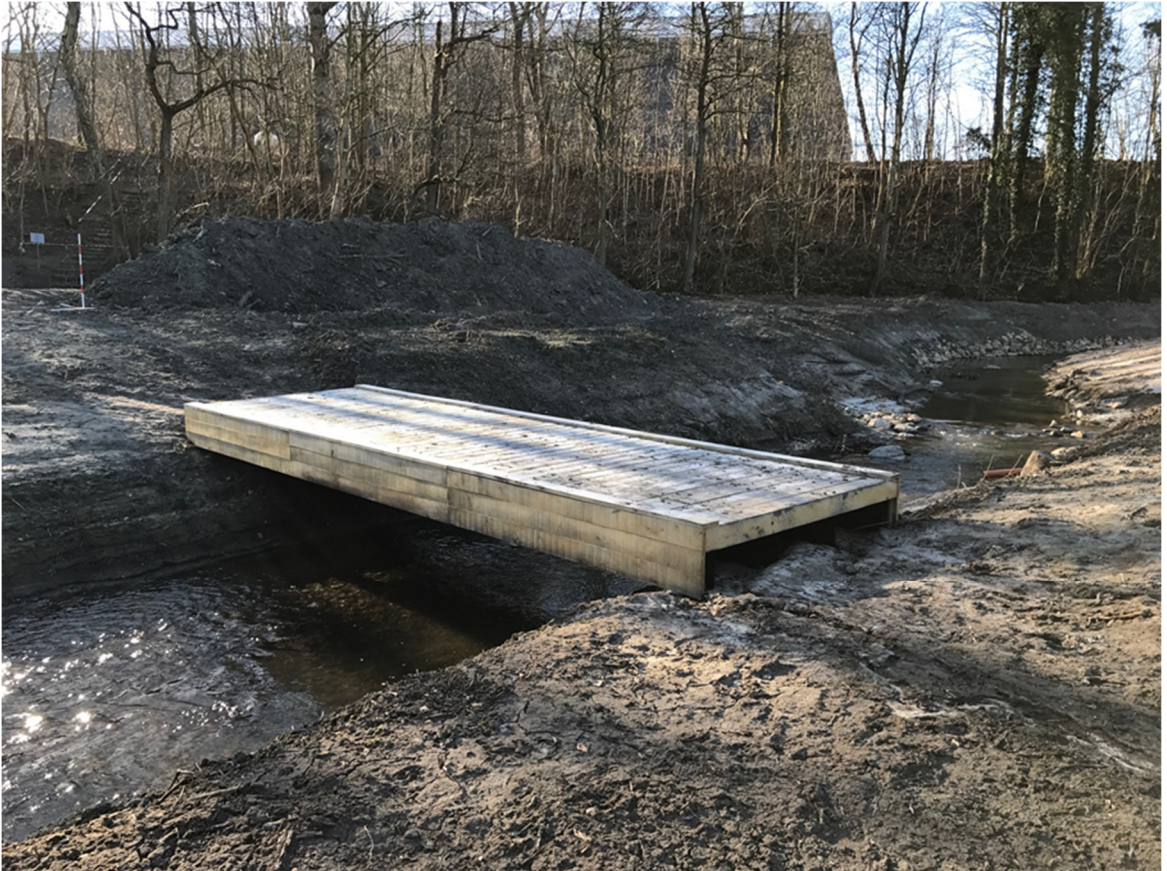
Figur 20.: Princip for grundopbygning af spang, type II (bemærk- stødplade og tildækninger ikke monteret på dette billede) . (Århus Kommune - Giber Å ved Wilhelmsborg)
