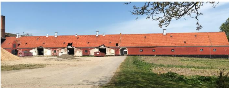
Sydlige længe efter nedrivning af 3 nedbrændte længer med svinestalde
