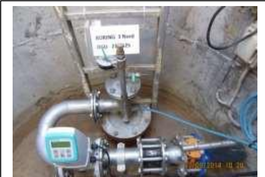
Boring 3. nord med DGU nr. 215.525
