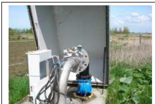
Boring med DGU nr. 217.187a
