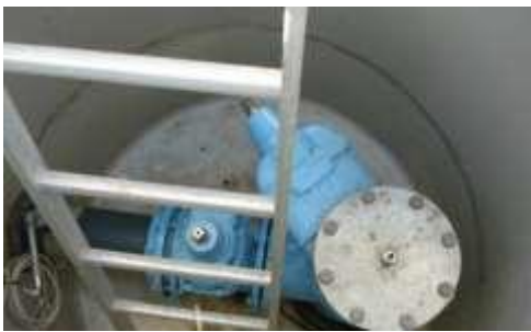
Boring med DGU nr..216.651 (1A)
