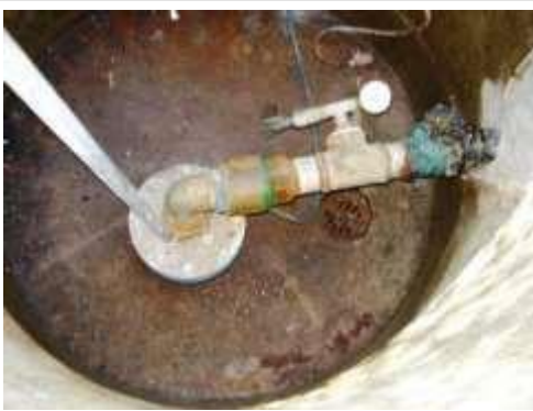
Boring med DGU nr. 222.205 (bero)
