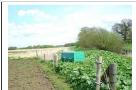
Boring med DGU nr. 217.187a
