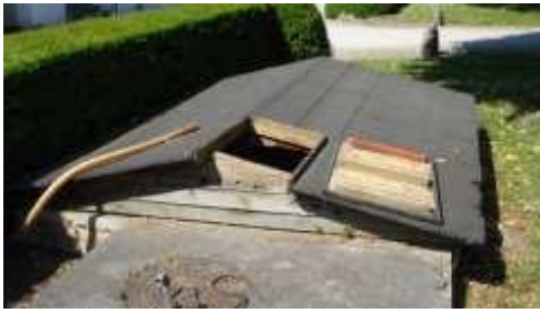
Bygning med Hydrofor for råvand
