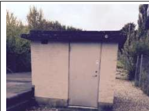
Boring med DGU nr. 216.63B
