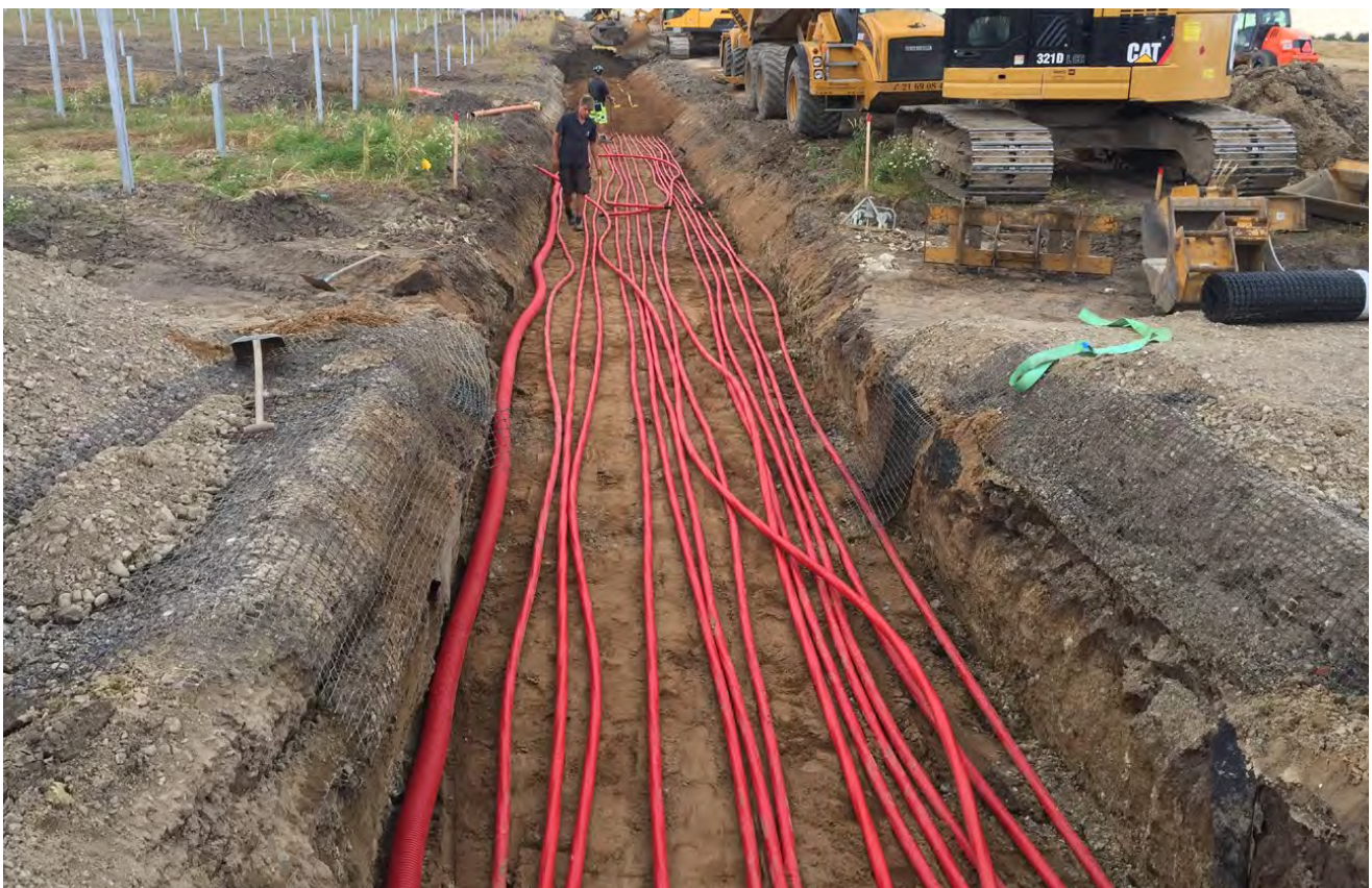
Figur 2.5. Gravearbejder i forbindelse med anlæg af solcelleanlæg (solcelleanlæg ved Lerchenborg, CGE).
