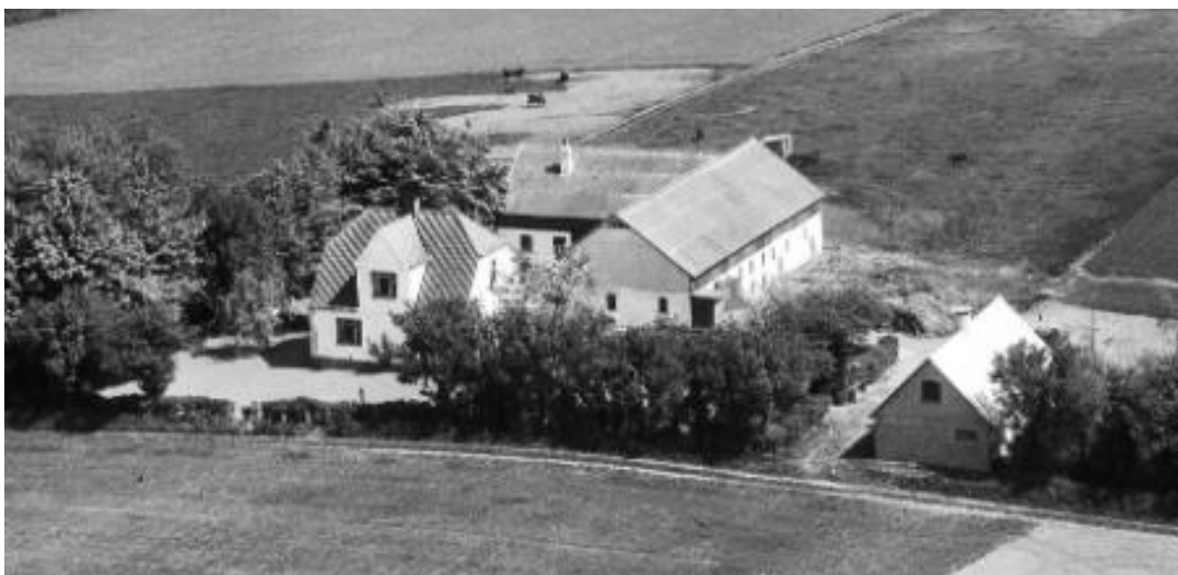
Luftfoto fra 1953 af landbrugsejendommen Fårupvej 27, 4700 Næstved. Danmark set fra luften. Stuehus og den lille bygning t.h. bevares, mens de to driftslænger er nedrevet til fordel for opførelse af et nyt stuehus.
