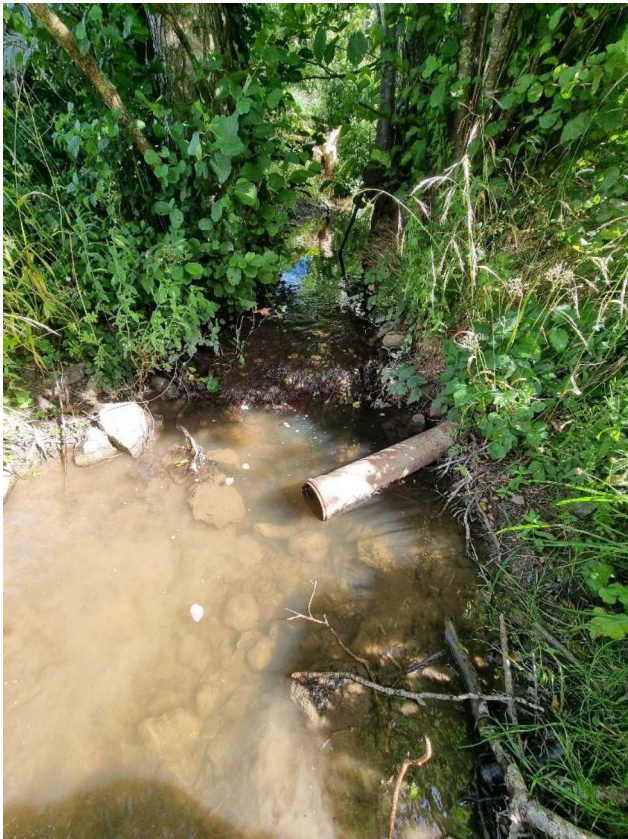
Foto 1: Udløb af rør i Fiskebæk mellem delstrækning 1 og 2 fra østlig mose på matr.nr. 3d Brandelev by, Næstelsø.
