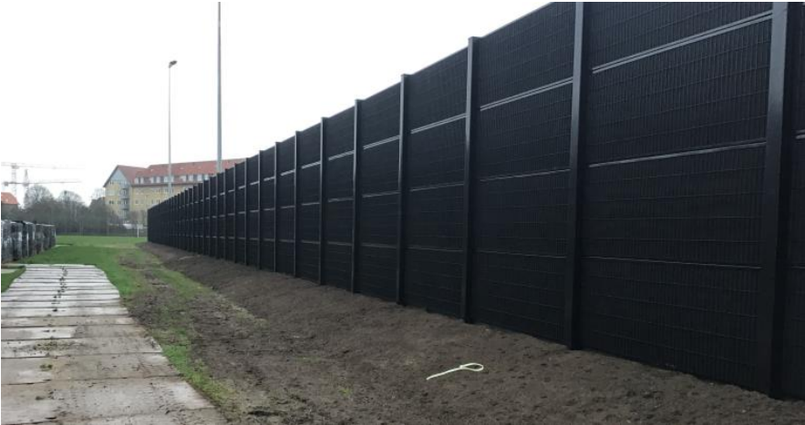
Eksempel på samme type støjskærm, dog på 4 m/ med 4 paneler i højden, fra anden lokalitet – fra ansøgningsmaterialet
