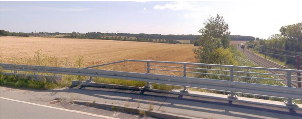
Cowi gadefoto 1. august 2024, som viser udsigten mod Sandby mod syd, hvor Tyvelsevej krydser Ringsted-Femern jernbanen.
