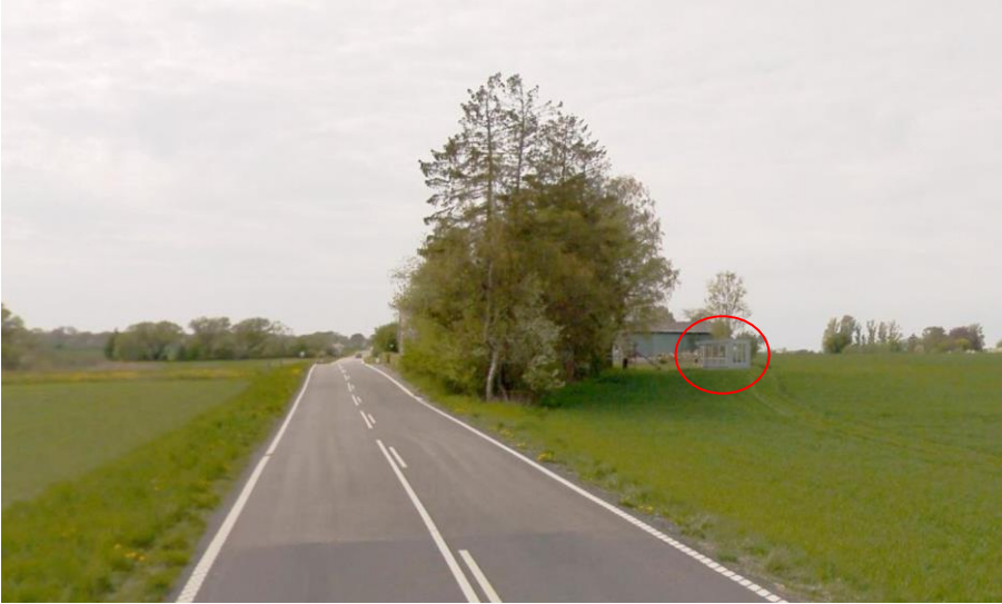
Trælløsevej 62, 4160 Herlufmagle med pavillon i højre side af billede vist med rød cirkel. COWI, 2022.
