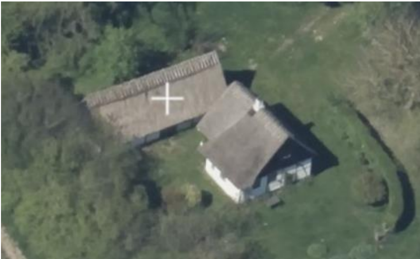
Bebyggelsen på Stavnstrupvej 14, 4733 Tappernøje, inden nedrivning af udhusbygningen (hvidt kryds), som søges genopført. SDFE skråfoto 2023.
