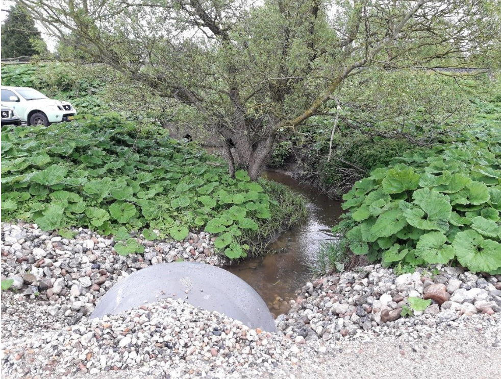
Foto 4. Opstrøms rørbroen kan man skimte underføringen under banen.
