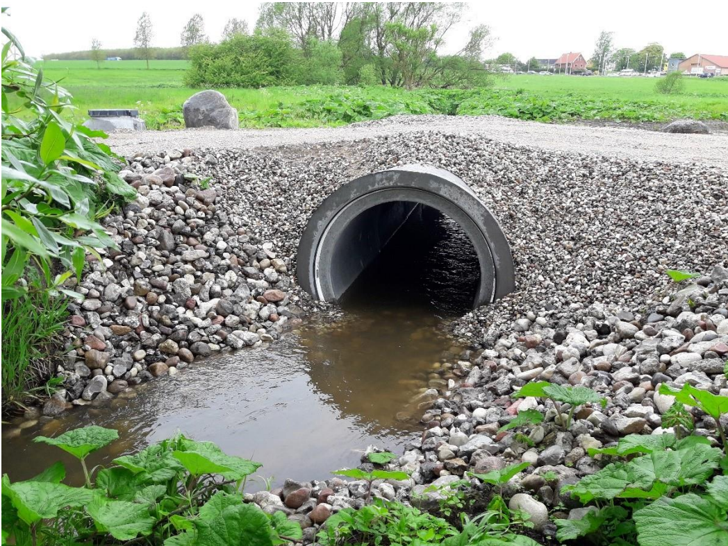
Foto 3. Rørbro i projektområdet. Den udgør ikke en spærring.
