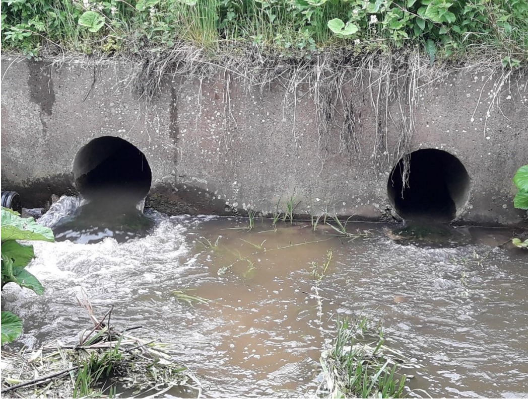
Foto 2. Rørføring under banen på den nedstrømsside. Foto maj 2021.
