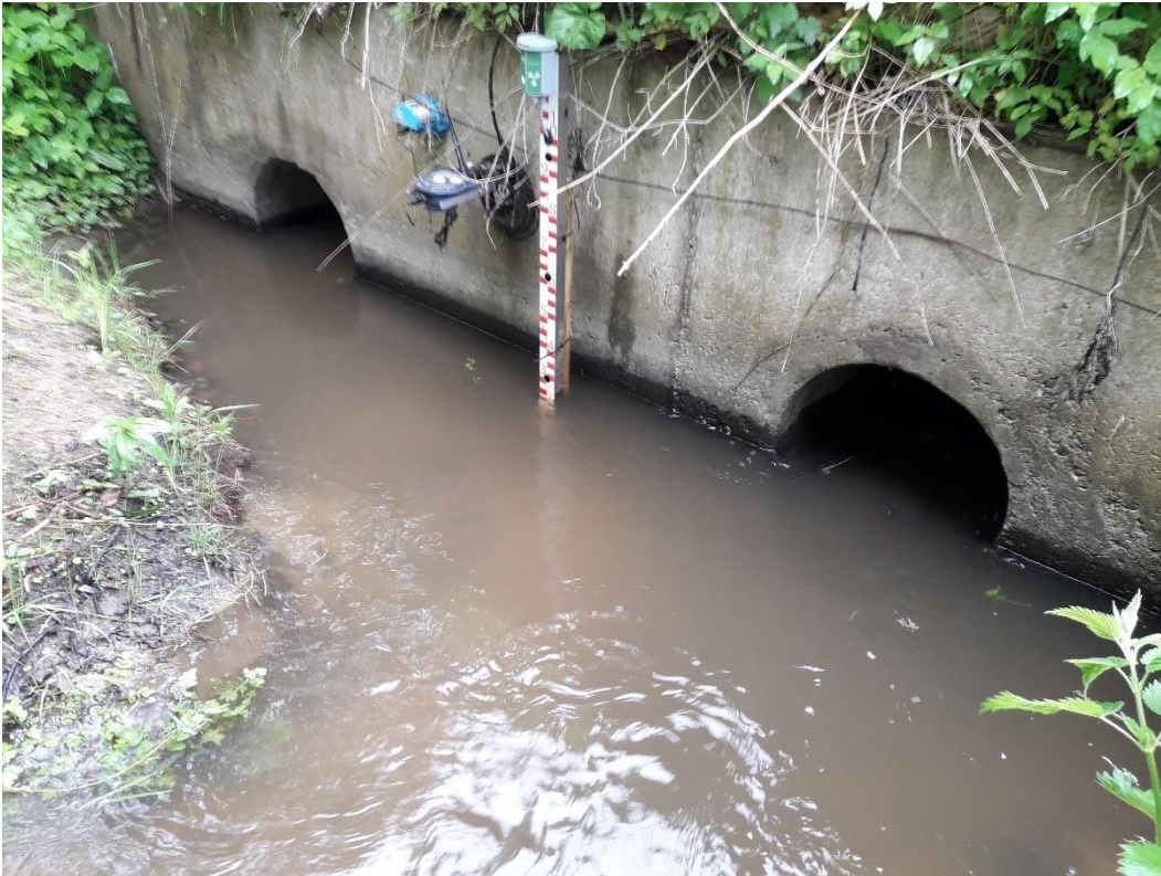
Foto 1. Rørføring under banen på den opstrømside. Foto maj 2021.
