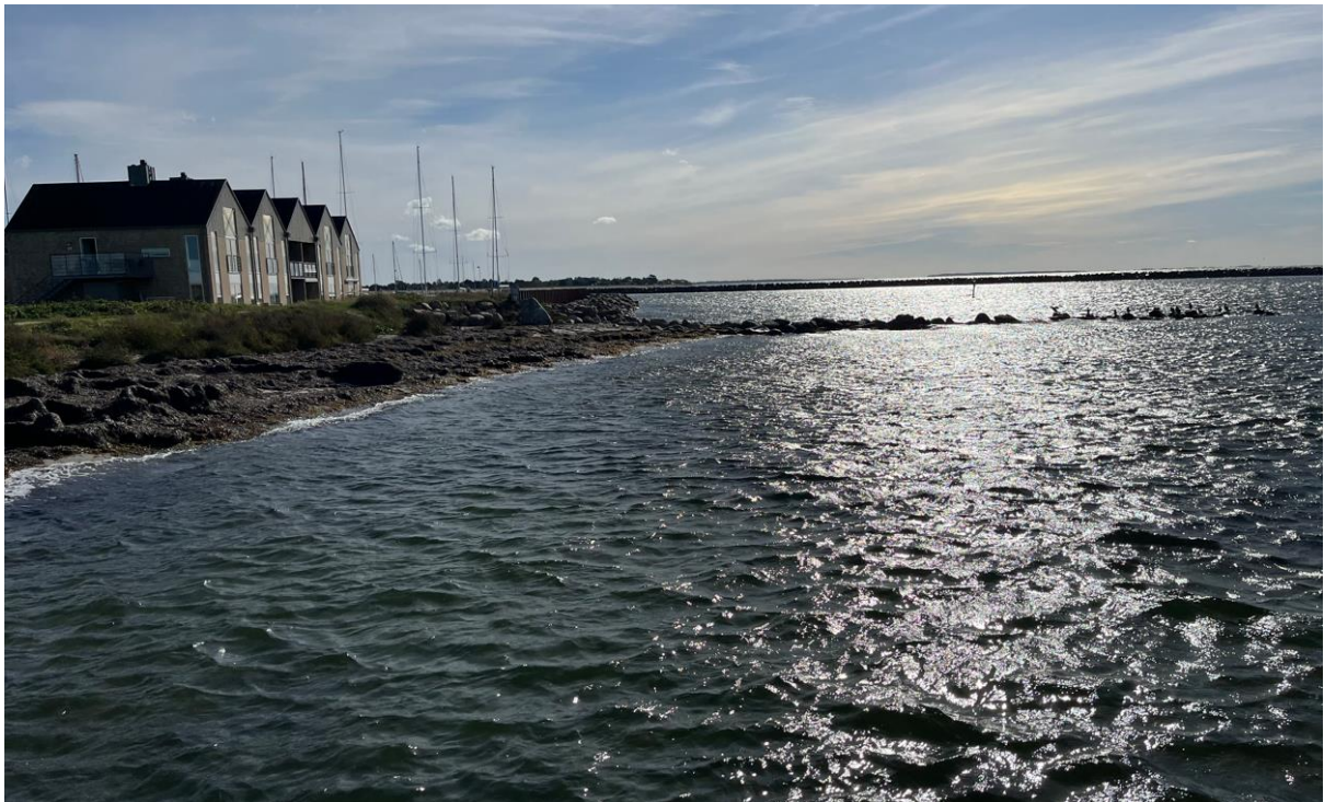
Figur 4 Oversigtsbilleder af stranden og diget set fra nord mod syd. Øverst: den nordlige del af stranden. Nederst den sydlige del af stranden set fra samme position med hofde og eksisterende stensætning i baggrunden og bagvedliggende beboelse Søfronten (Foto: WSP 2024)
