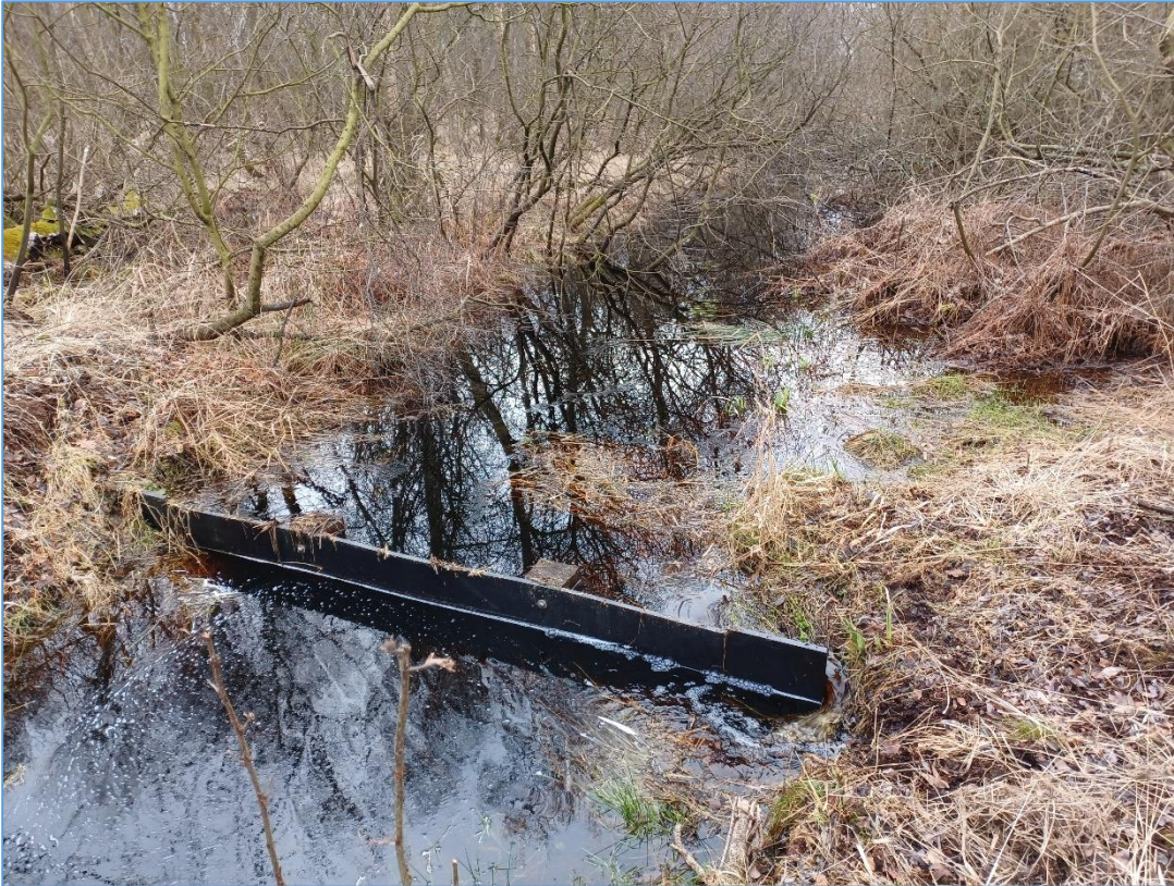
Figur 1. Større spuns i tørveskær T70 som skal brinksikres pga omløb under kotehøjden.
