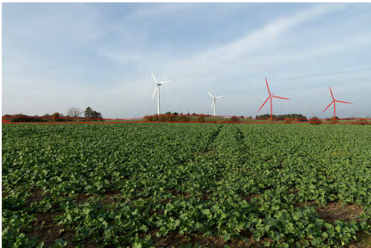
Figur 4-40 Visualiseringspunkt 8 – Visualisering af anlæggets udstrækning med rød markering
